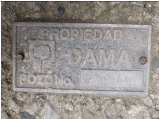
Foto No. 4. Placa de identificación del DAMA
