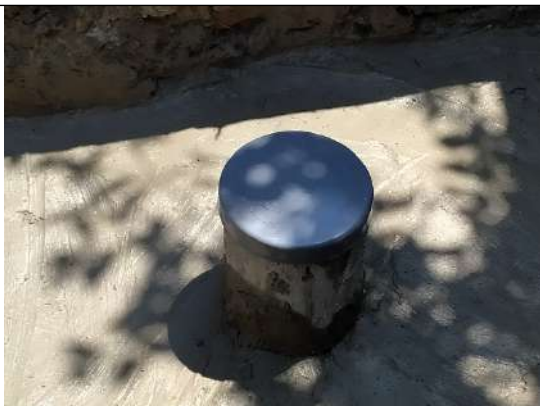
Foto No. 15. Instalación de tapón de 4" en PVC
