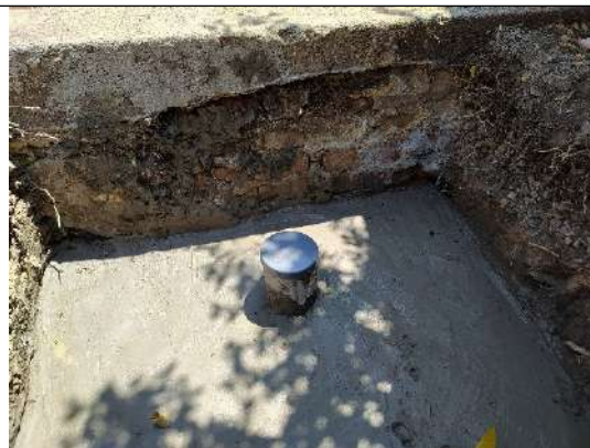
Foto No. 16. Aplicación de mezcla de bentonita hidratada
