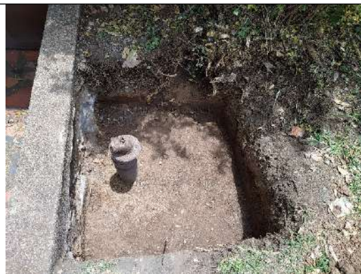
Foto No. 8. Área de la boca del pozo despejada
