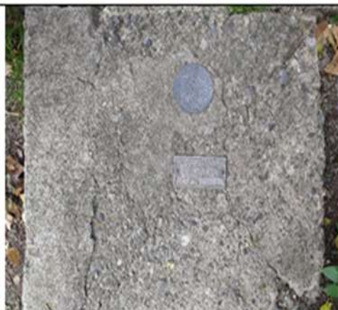
Foto No. 3. Placa de concreto que cubre el pozo
