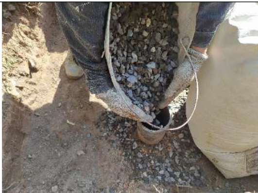
Foto No. 13. Relleno con grava 8-12
