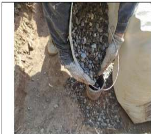
Foto No. 13. Relleno con grava 8-12
