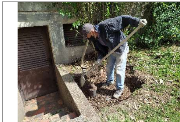
Foto No. 7. Excavación de 1mX1m y 50cm de profundidad
