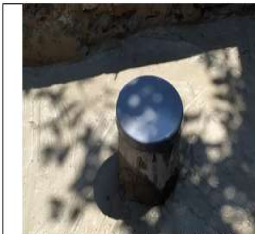
Foto No. 15. Instalación de tapón de 4" en PVC
