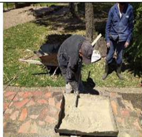
Foto No. 14. Mezcla de bentonita ARCICOL, cemento y agua
