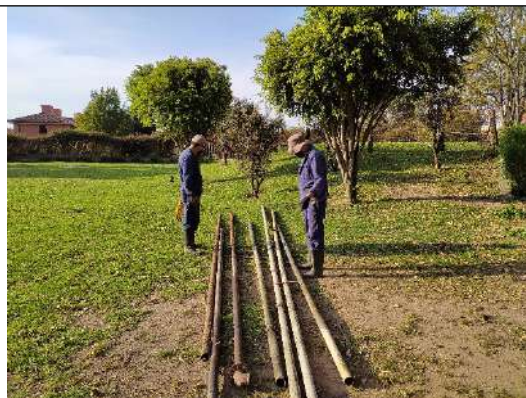
Foto No. 11. Total de tramos de tubería interna
