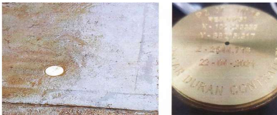
Imagen No. 3. Vista del sellamiento definitivo del pozo y placa de identificación instalada Fuente. 2021ER82869 de 04/05/2021
