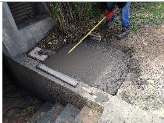
Foto No. 18. Nivelación de placa de concreto
