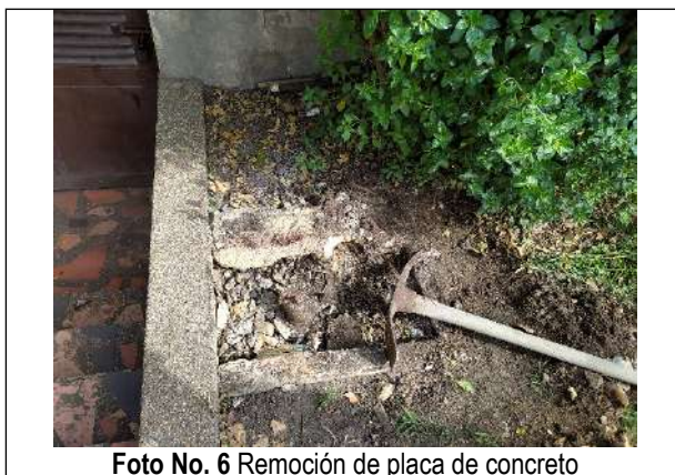
Foto No. 6 Remoción de placa de concreto
