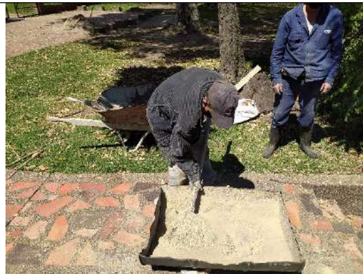
Foto No. 14. Mezcla de bentonita ARCICOL, cemento y agua
