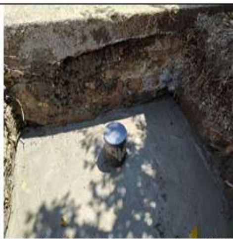
Foto No. 16. Aplicación de mezcla de bentonita hidratada
