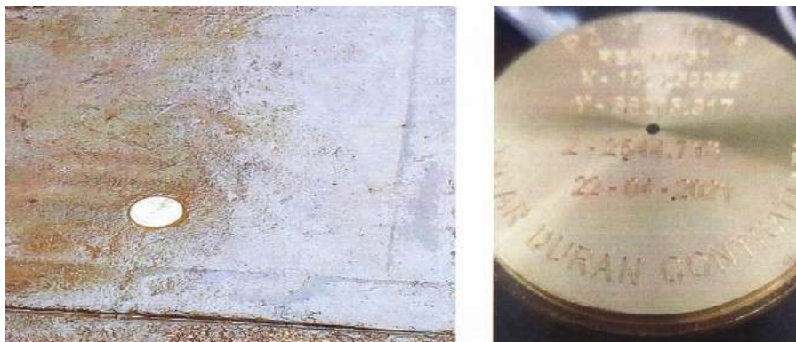
Imagen No. 3. Vista del sellamiento definitivo del pozo y placa de identificación instalada Fuente. 2021ER82869 de 04/05/2021
