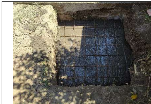
Foto No. 17. Placa de concreto, reforzada en varilla de 3/8"
